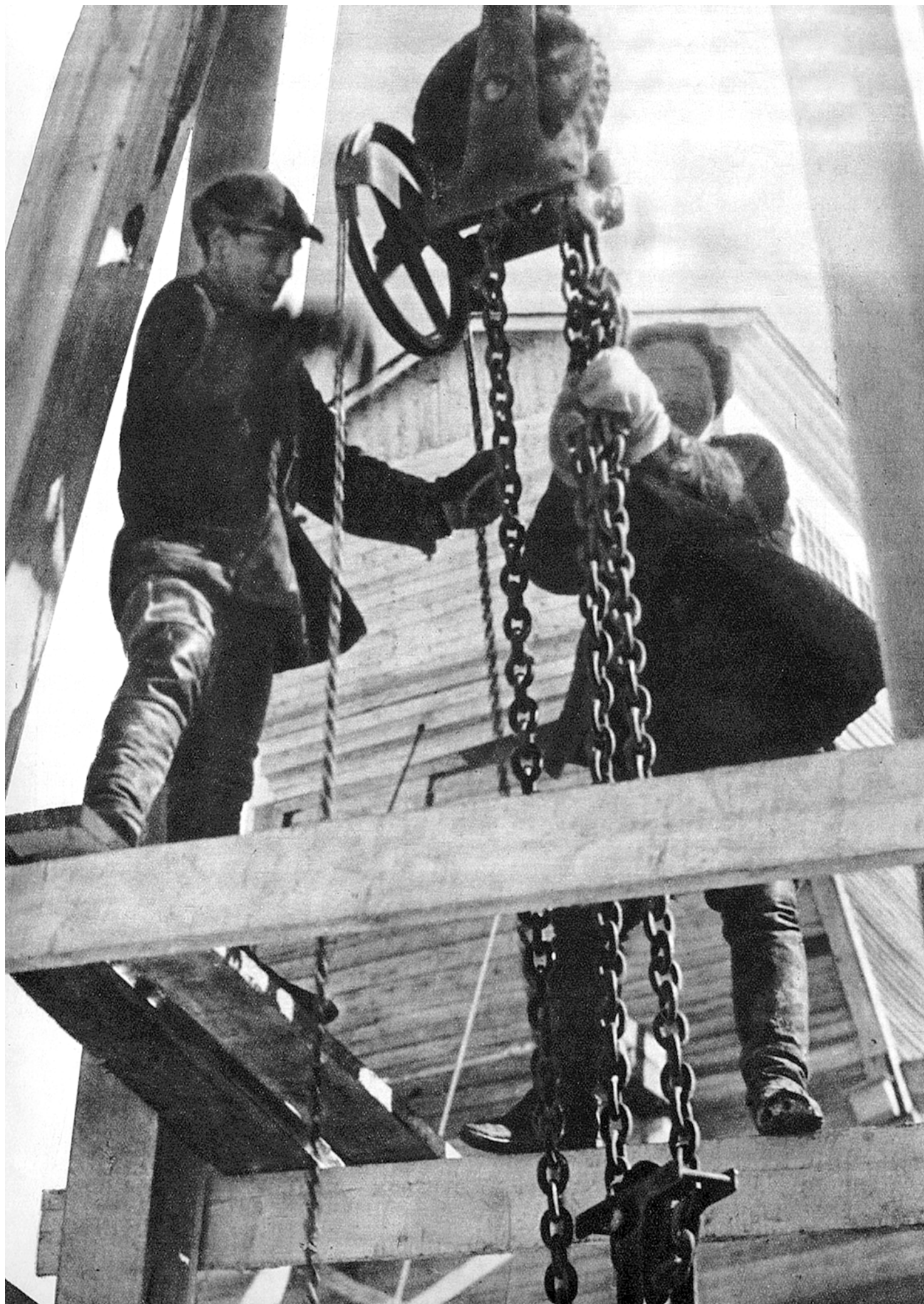
На фото: строительство копра
